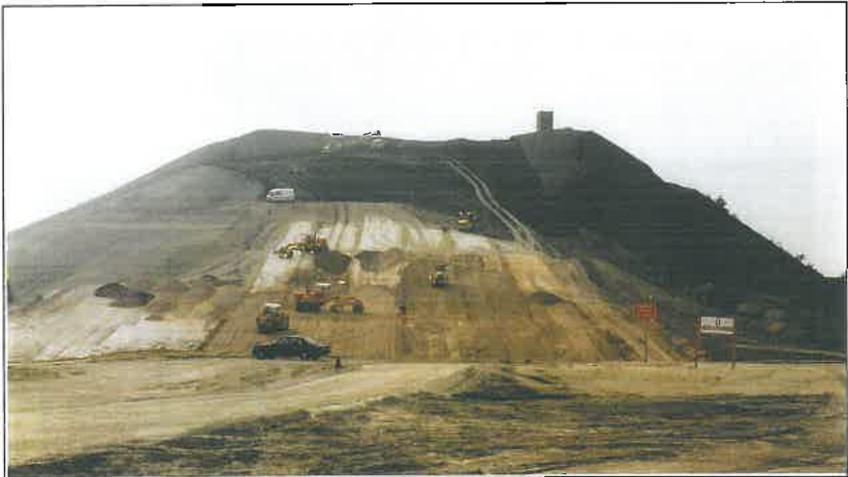
Figure 4 : Vue du terril 42a durant les travaux de terrassement
